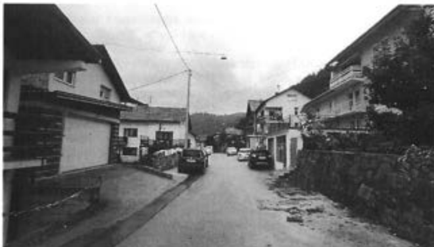
Fotografija br. 3: Fronta niza individualnih stambeno-poslovnih objekata u sjevernom dijelu obuhvata
